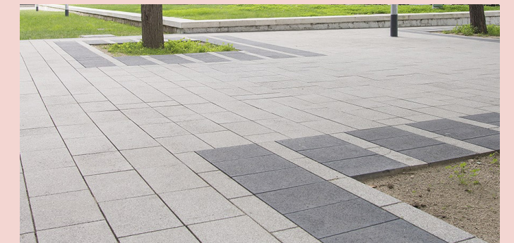
Referència 10 Paviment drenant i resistent, projecte de rehabilitació, Cornellà de Llobregat. Font: Breinco.
